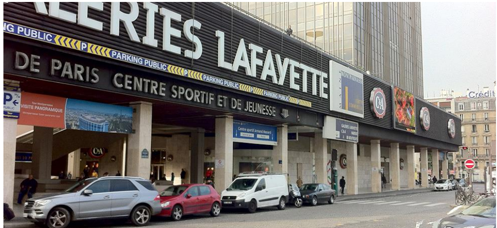
Le Centre Commercial Montparnasse, vu de la rue de l'Arrivée
